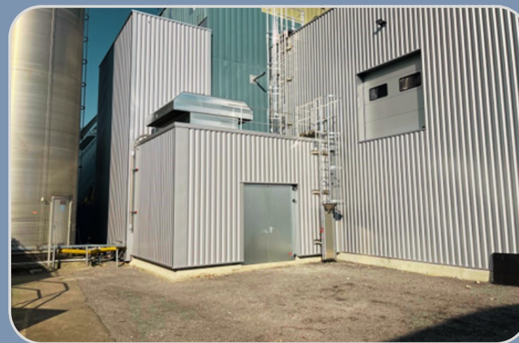
Extension d'un bâtiment industriel
